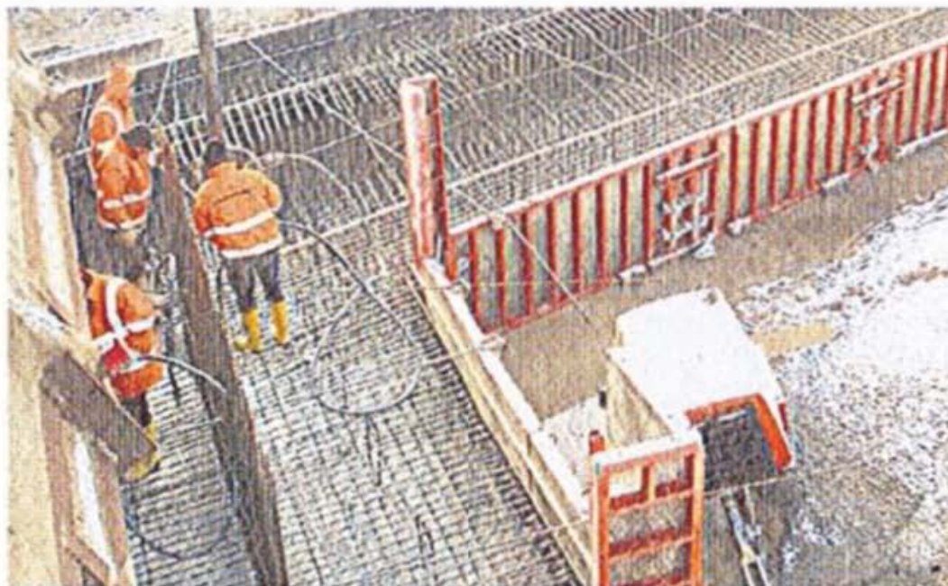
Arbeiten an der neuen Autobahnbrücke über die Müritz-Elde-Wasserstraße – die Gründung an der Berliner Seite ist inzwischen abgeschlossen.
