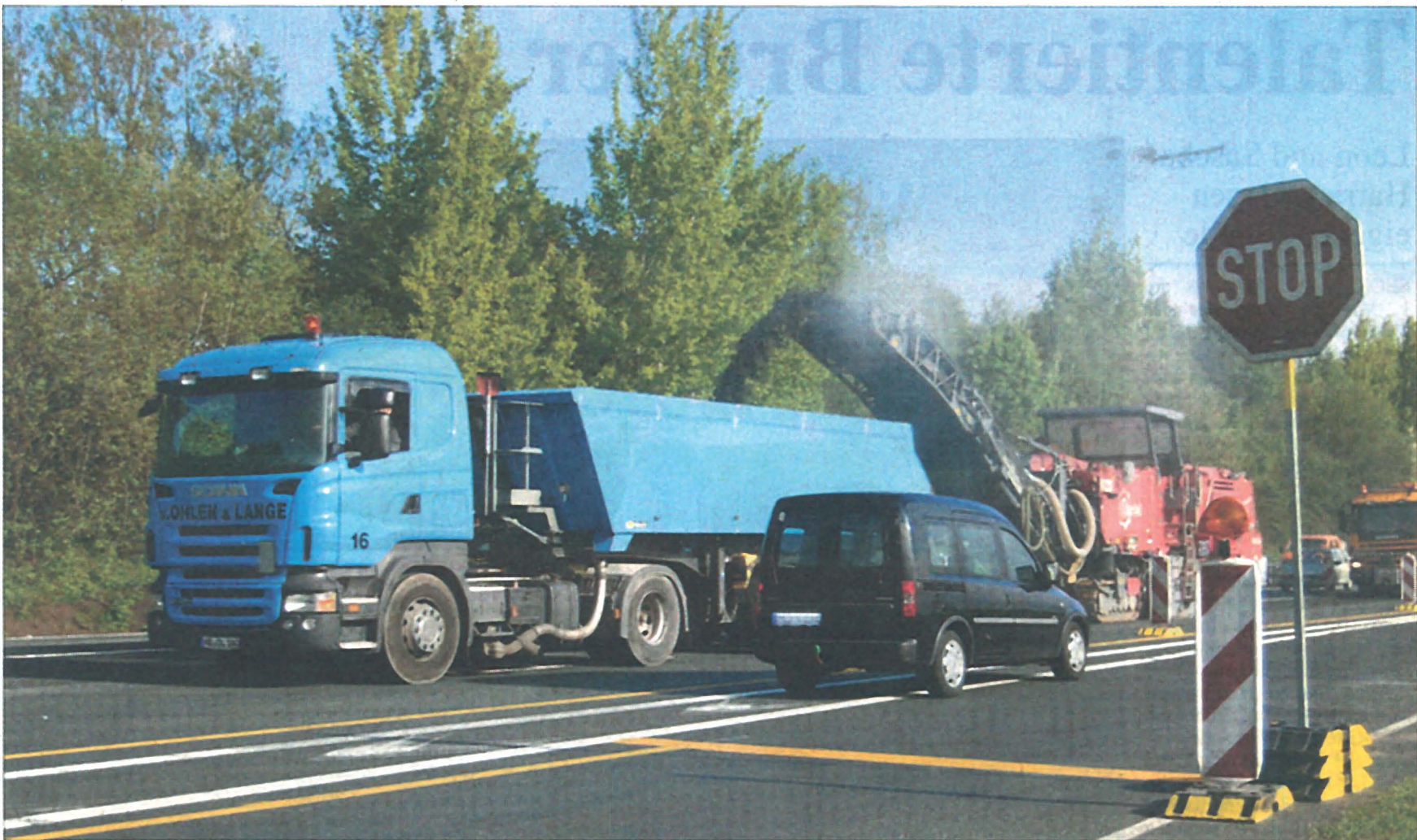
AM WOCHENANFANG wurde der alte Belag in der Fahrbahnmitte der Brinkumer Ortsumgehung abgefräst, während der Verkehr weiterfließen konnte. Foto: Beer
