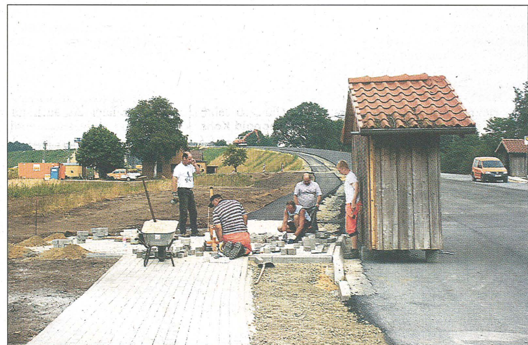
Gestern gemacht: die neue Bushaltestelle am Bahnübergang Förth in Fahrtrichtung Verden und Dauelsen..
