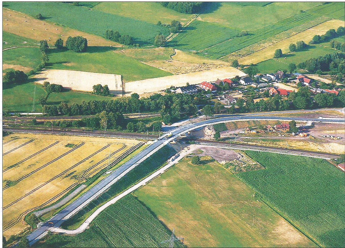
Nur noch Restarbeiten sind an der Bahnüberführung in Langwedel-Förth zu erledigen. Im August ist mit der Freigabe der Brücke zu rechnen, dann gehört der alte Bahnübergang endgültig der Vergangenheit an.
