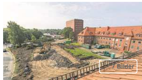
So sah das Baufeld im August 2015 aus.
