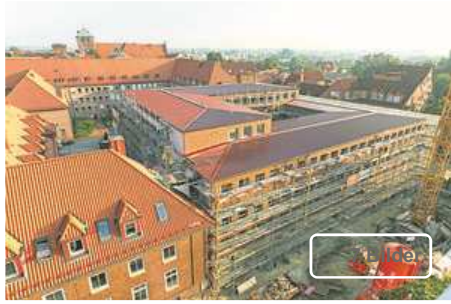
Der Bau vor wenigen Tagen vom Staatsarchiv aus fotografiert: Laut Gestaltungssatzung der Stadt Stade muss das Dach in roter Farbe eingedeckt werden. Der Innenhof wird begehbar sein
