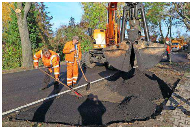
Nur die Grundstückszufahrten werden noch gebaut.
