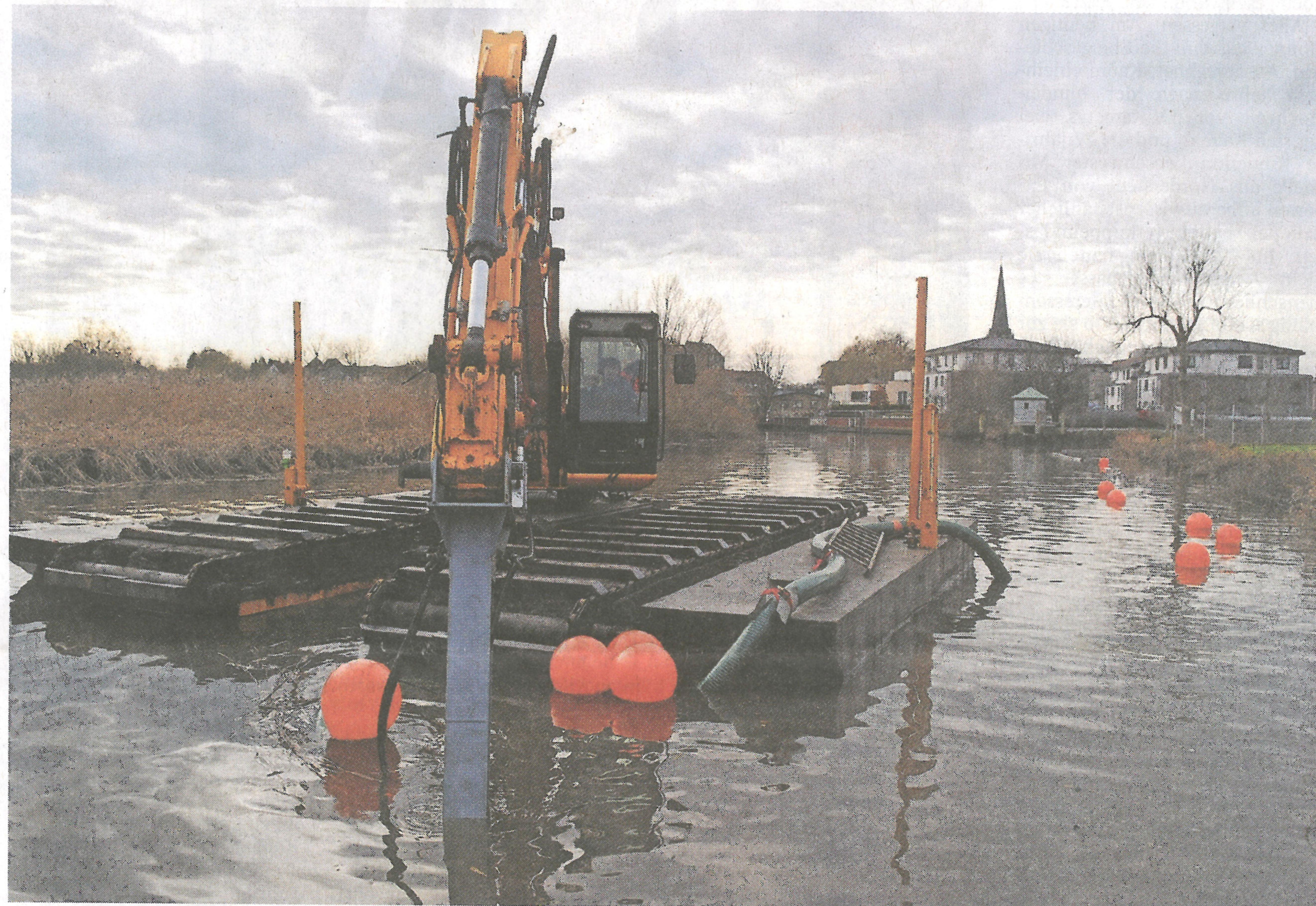
Der Schwimmbagger von Matthäi Wasserbau legt die Este auf Höhe des WSA-Betriebshafens an der Estebrügger Straße tiefer.
