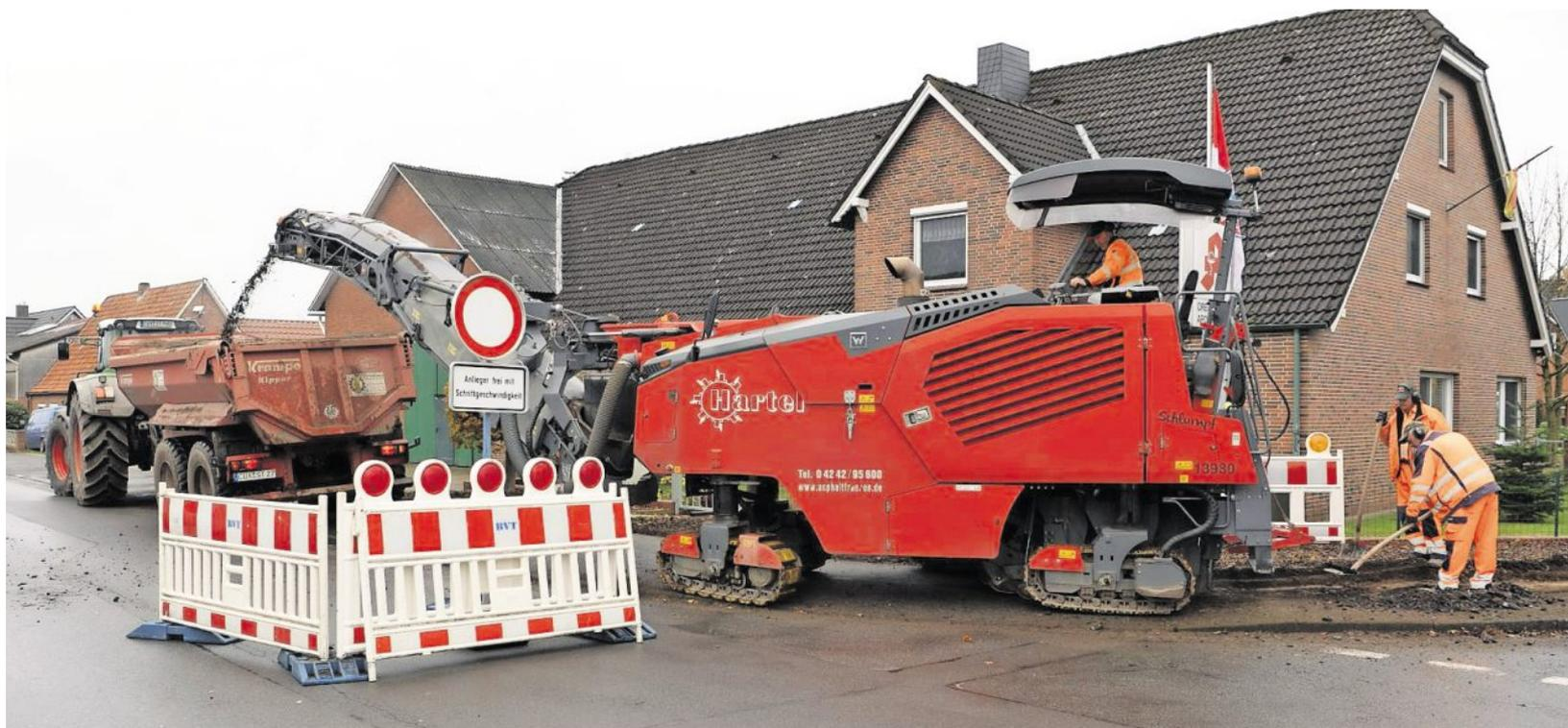
Am Mittwochmorgen rückten die Bauarbeiter der Firma Matthäi in Lamstedt an. Zunächst wird der Radweg abgefräst, danach folgt die **Sanierung der Straßenentwässerung**. Im letzten Bauabschnitt wird die Straße komplett neu aufgebaut und die Asphaltdecke erneuert. Fotos: Schult
