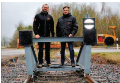
Sven Markwart (rechts) und Jörn Maciejewski betreuen die Erneuerung des Gleisanschlusses für den Bauhof der Firma Matthäi in Hohenwulsch.
