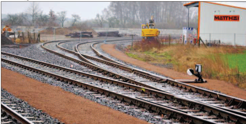
Das Bauunternehmen Matthäi Stendal hat für seinen Bauhof in Hohenwulsch den seit Jahrzehnten vorhandenen Gleisanschluss aktiviert und erneuert.
