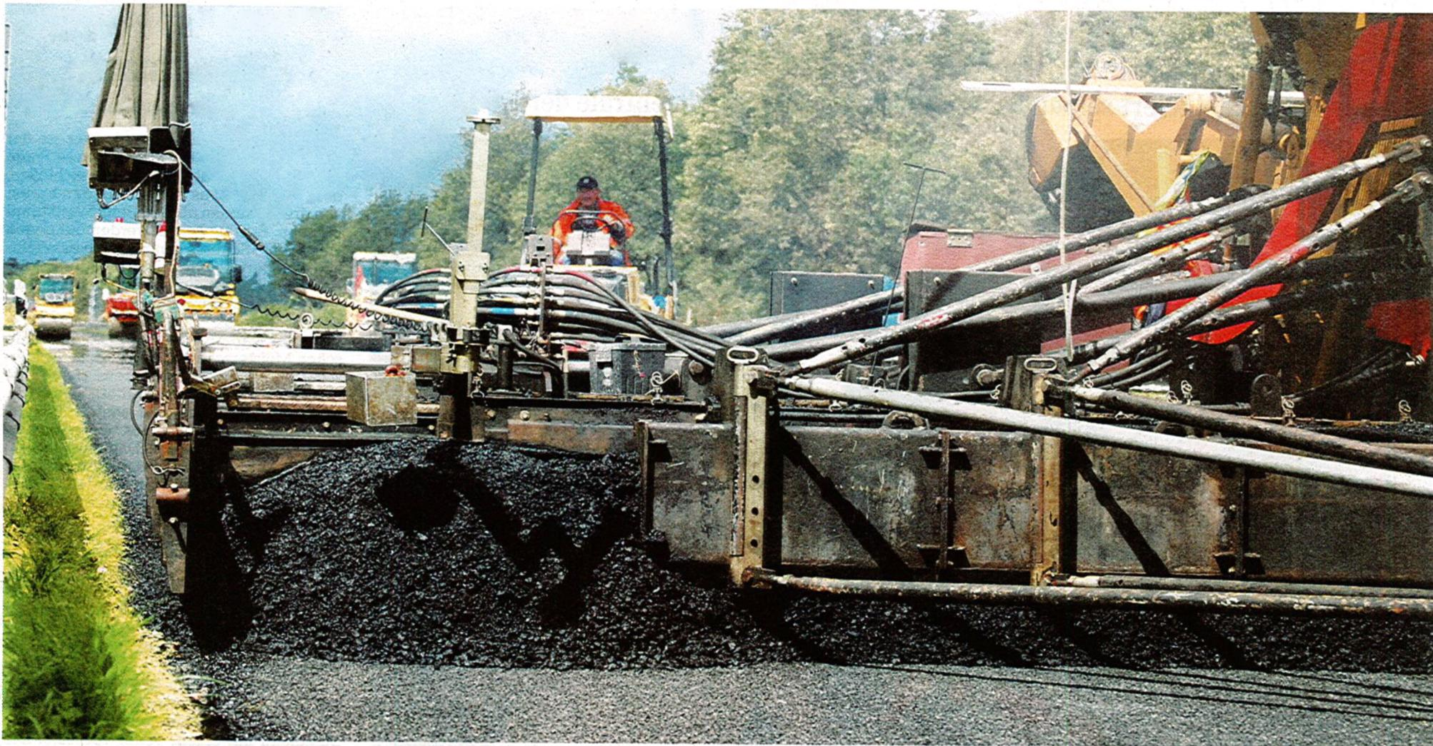
Mit diesem Monstrum von Maschine wird die Asphaltdecke auf einer Breite von 11,5 Metern in zwei Schichten in einem einzigen Arbeitsgang hergestellt.
