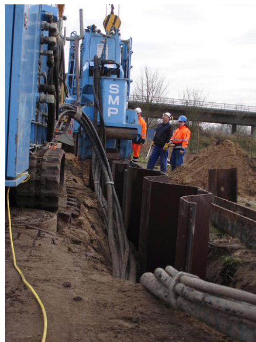
Die Bleche für die Spundwand werden in den Untergrund gepresst.
