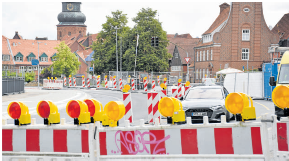
Die Kreisels-Baustelle am Schiffertor , nahe der Altstadt: Die Straße gen Innenstadt ist gesperrt.
