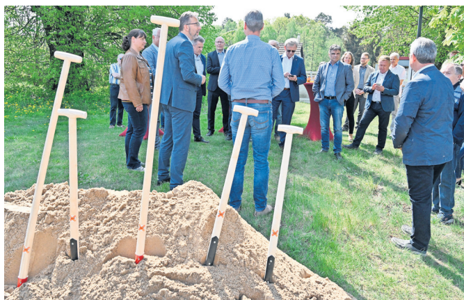
Die ersten Spatenstiche sind vollbracht. Gestern hat der Ausbau der Straße zwischen Tornow und Fürstenberg begonnen.
