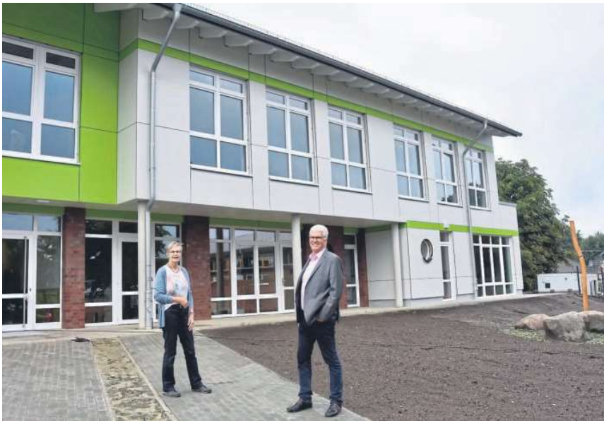
Das neue Schuljahr kann nun kommen: Karin Stegmann und Ralf Goebel freuen sich über die Fertigstellung der Arbeiten am Campus.
